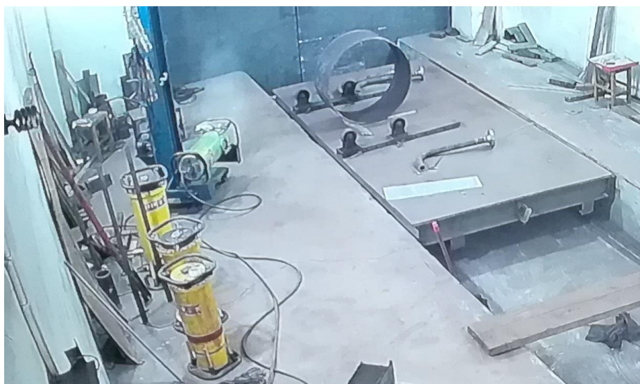
A 本次验收的四台探伤机及曝光室内情况
