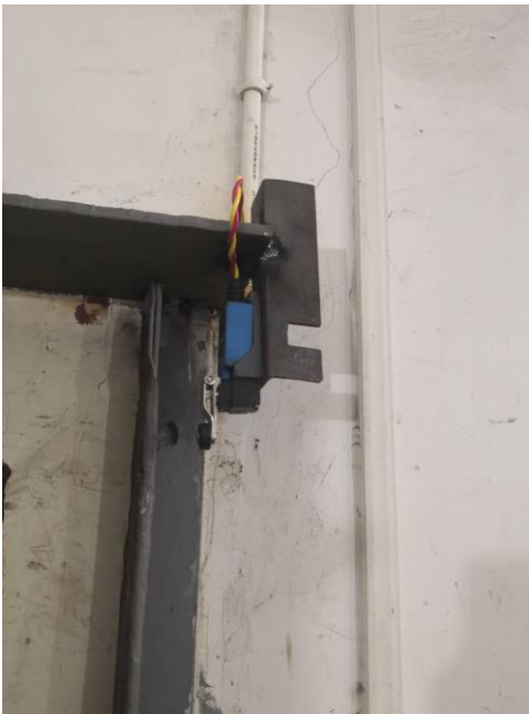
E 人员出入防护门门机连锁装置
